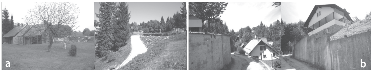
Slika 9: (a) Zatravitev in zasaditev brežine ali uporabe kamnov za reševanje višinskih razlik, ograditev parcele z živo mejo in ograjo ob vhodu, (b) betoniranje visokih opornih zidov in položitev strešne kritine na vrh betonirane brežine (foto: Tanja Oberžan)
