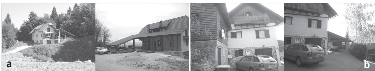
Slika 4: (a) Obnova počitniške hišice in dozidava objekta z vseh strani na nagnjenem terenu (garažni nadstrešek, garaža v hiši, gradnja nadstropja), (b) dozidava novega objekta ob obnovljeni starejši počitniški hišici (foto: Tanja Oberžan)
